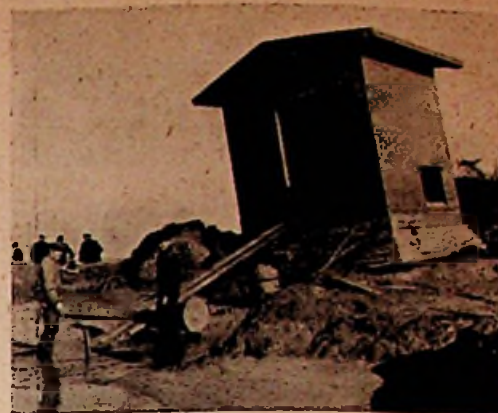
Foto hierboven: Tengevolge van een dijkbreuk bij Burghsluis naast een trafostation, verzakte dit ca. 2 meter. Het station is inmiddels verrold en omhooggebracht en doet weer normaal dienst.
